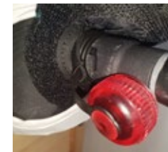
Photo 16 : flexible avec raccord attaché à la vanne.
